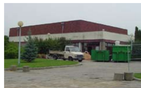
Septembre, préparation du chantier
