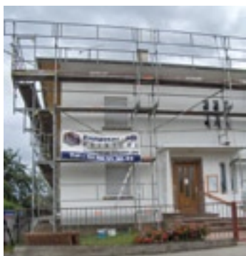
Notre bibliothèque en travaux
